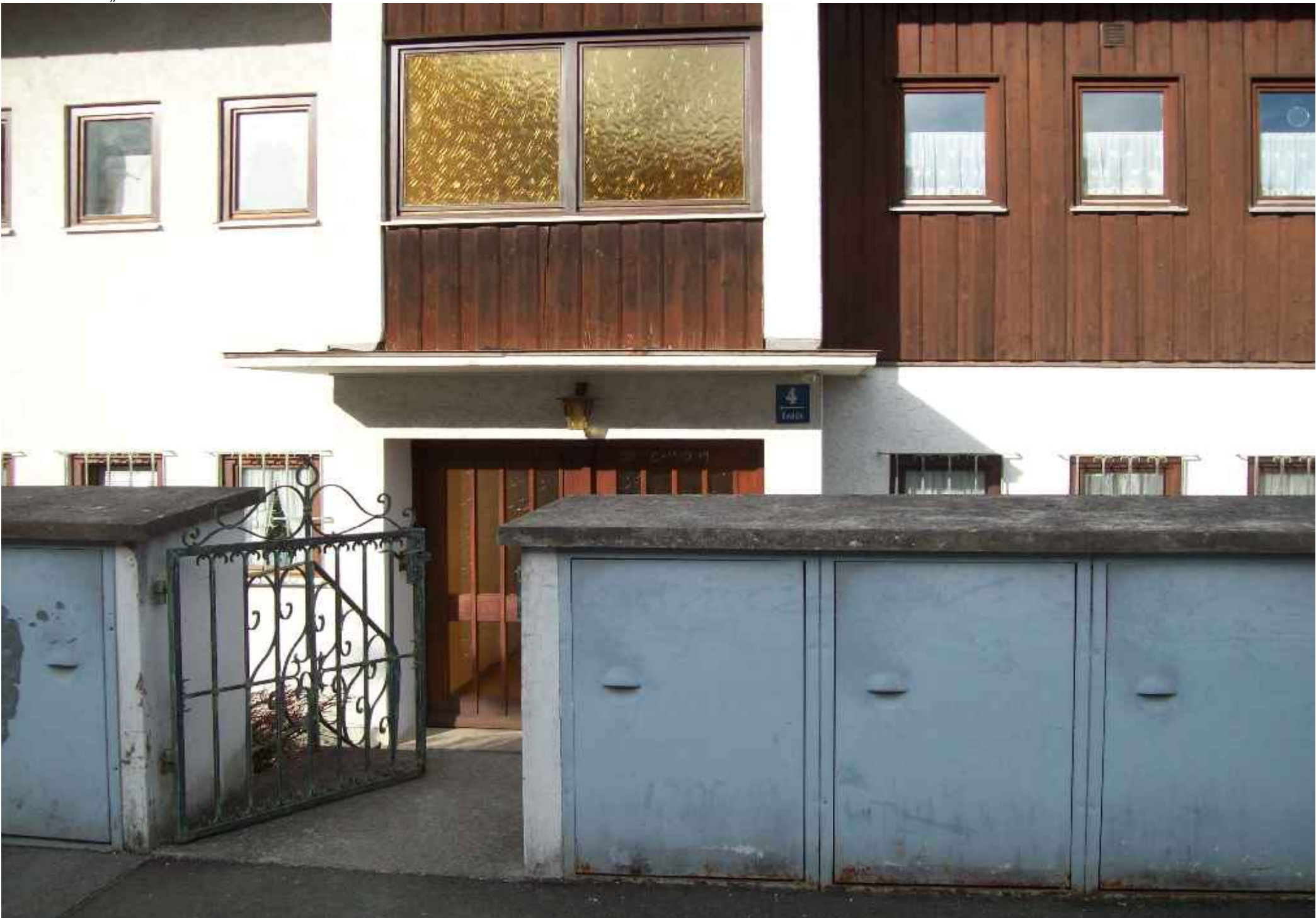
Dann kommt die „Rautstrasse 4“:
