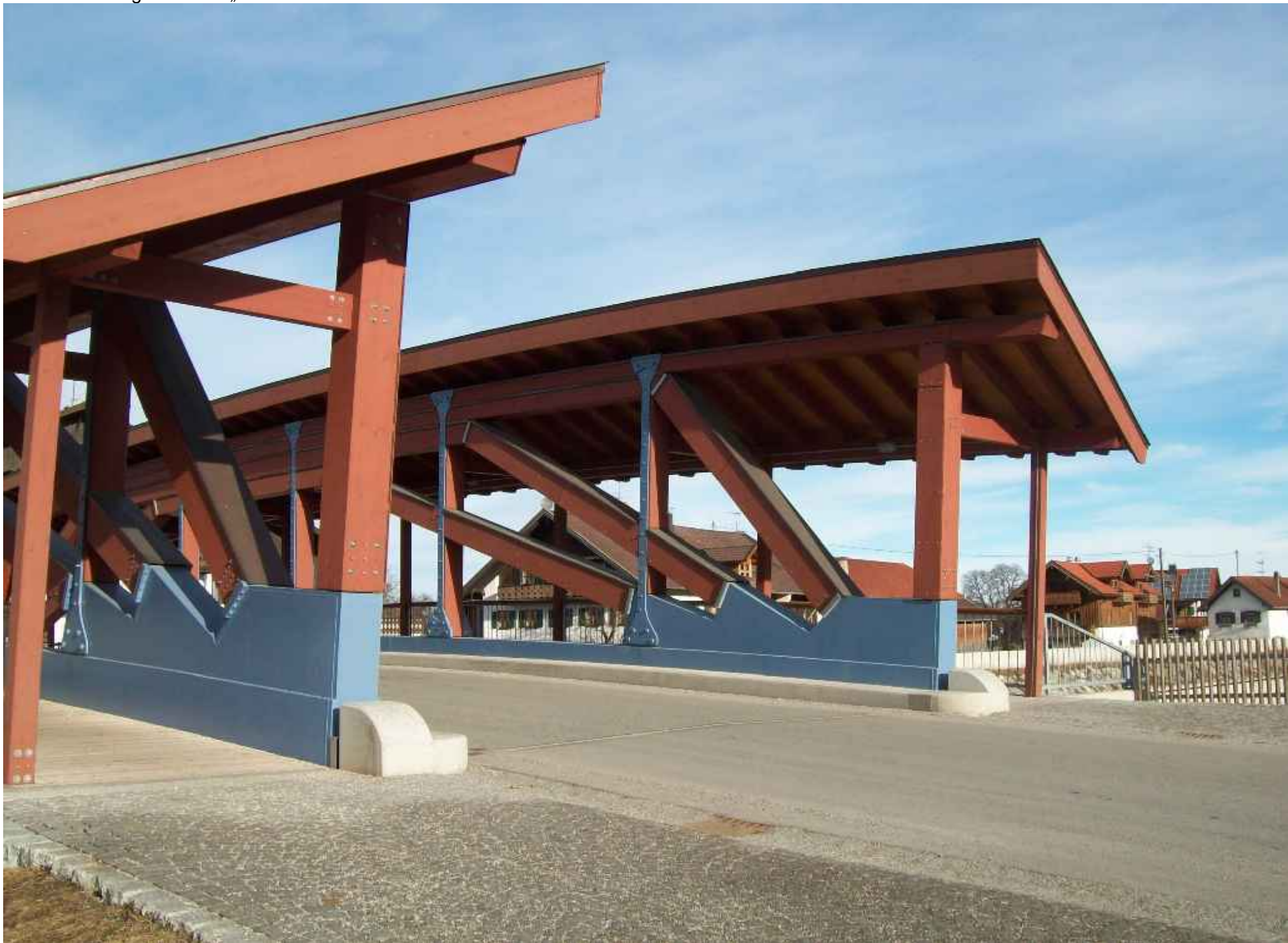
Hier sehen Sie die illegal erbaute „Loisachbrücke“:
